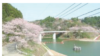
広川防災ダム
